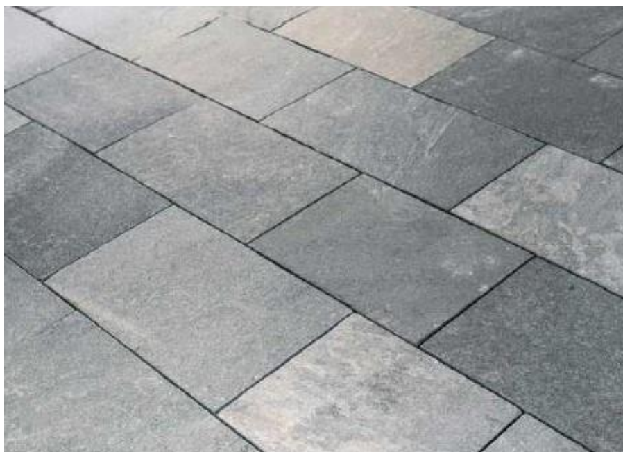
Εικόνα 10: Επίστρωση πεζοδρομίου με γκρι ορθογωνισμένες πλάκες φυσικού γρανίτη 40x60x2 εκ.
