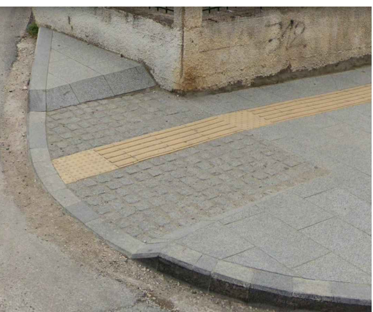
Ράβδος ΑΜΕΑ με γραμμωμένη επιφάνεια 12x20x40 εκ. για κροτάλετο πεζοδ.
